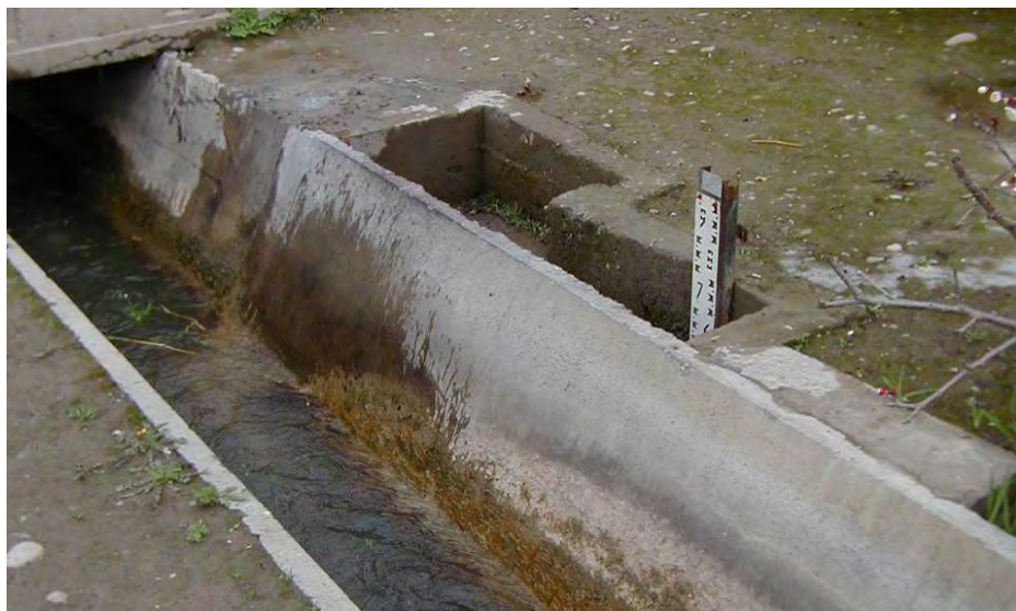
Параболический лоток с уровнемерным колодцем
